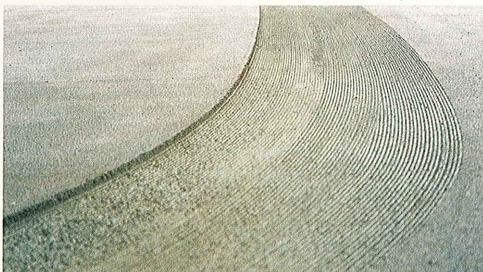
正確な作業：右は0cm左は2.5cmの深さのきれいなくさび形に切削されています
