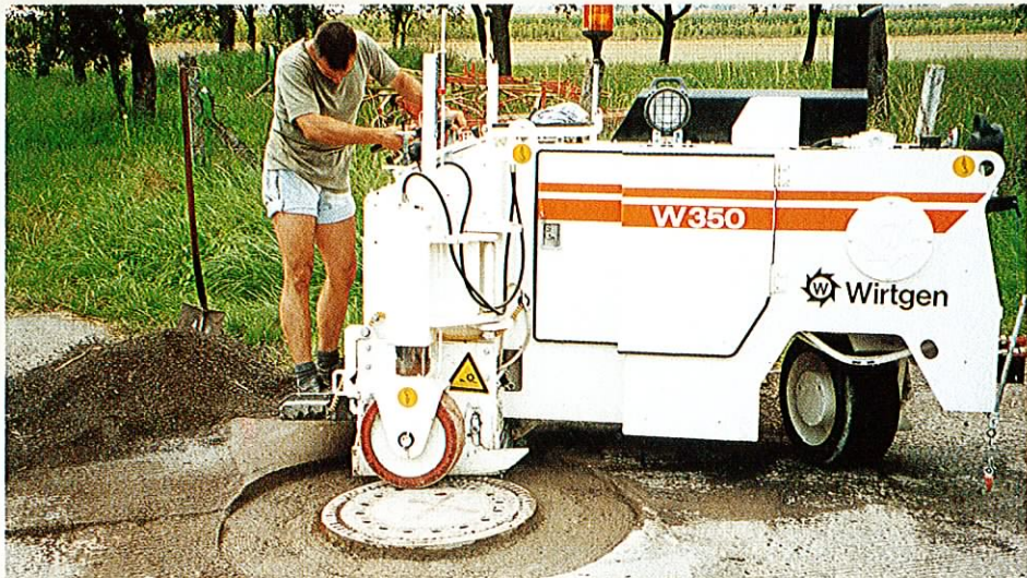
経費が高い手作業よりも綺麗に：マンホールの周りを切削
