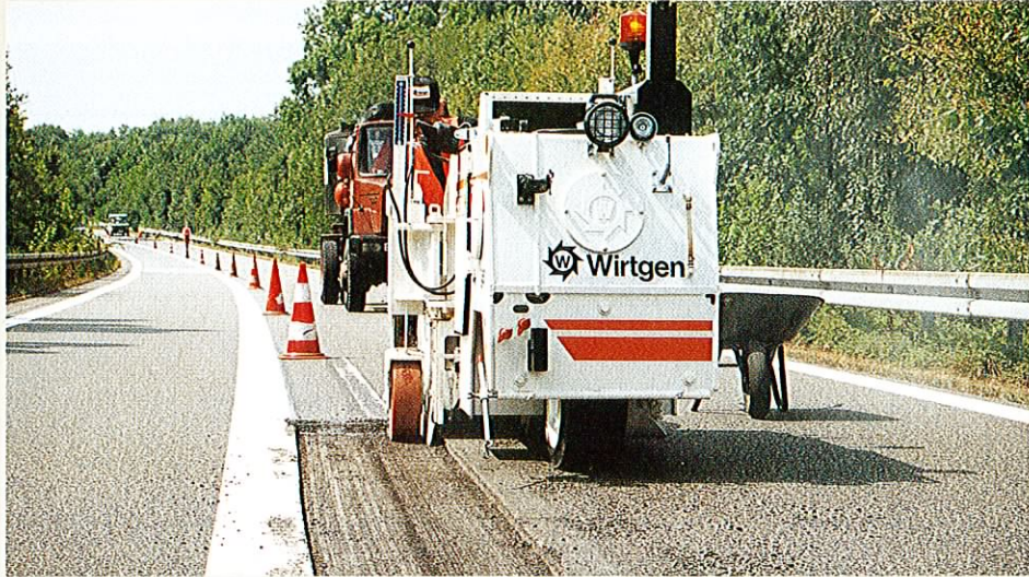
道路の進行方向に3回に分けて切削し、巾1mの道路表層を切削中
