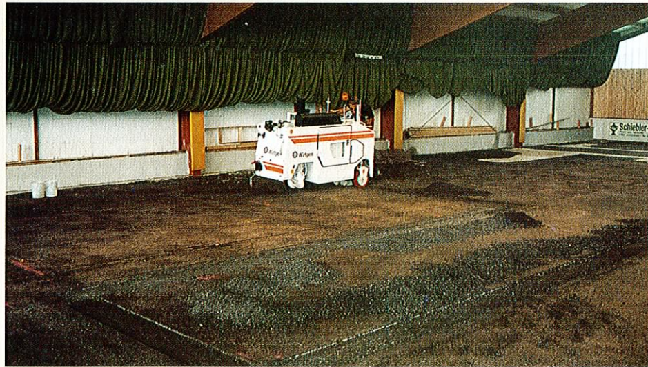
新しい材料で補填される場所のエッジ部分はくさび形に切削されます
