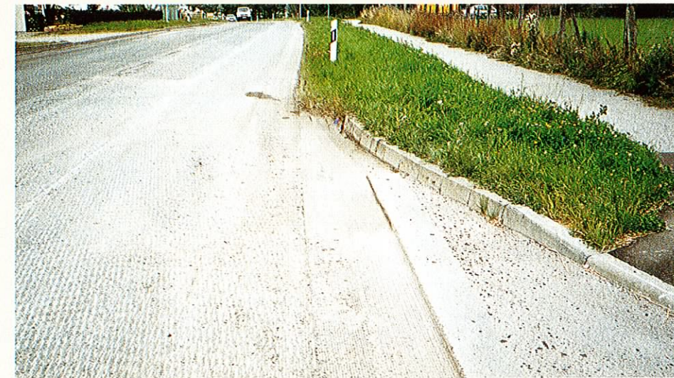
W350でエッジ部分を2回の作業で切削仕上げしてあります
