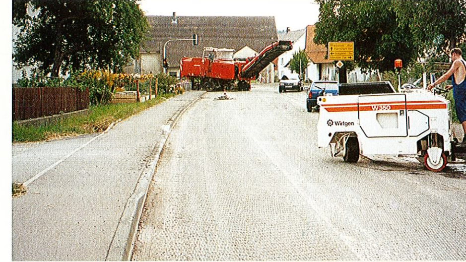
作業の分担：小さな町を通る主要幹線道大型機械が切削出来ない部分を除去するために現在待機中のW350
